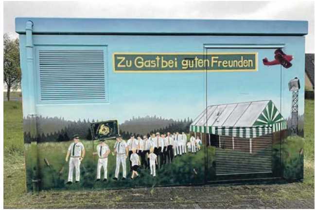
Die Trafostation an der Bischof-Ketteler-Straße hat nun einen Kohvedel-Look. DZ-Foto: privat
